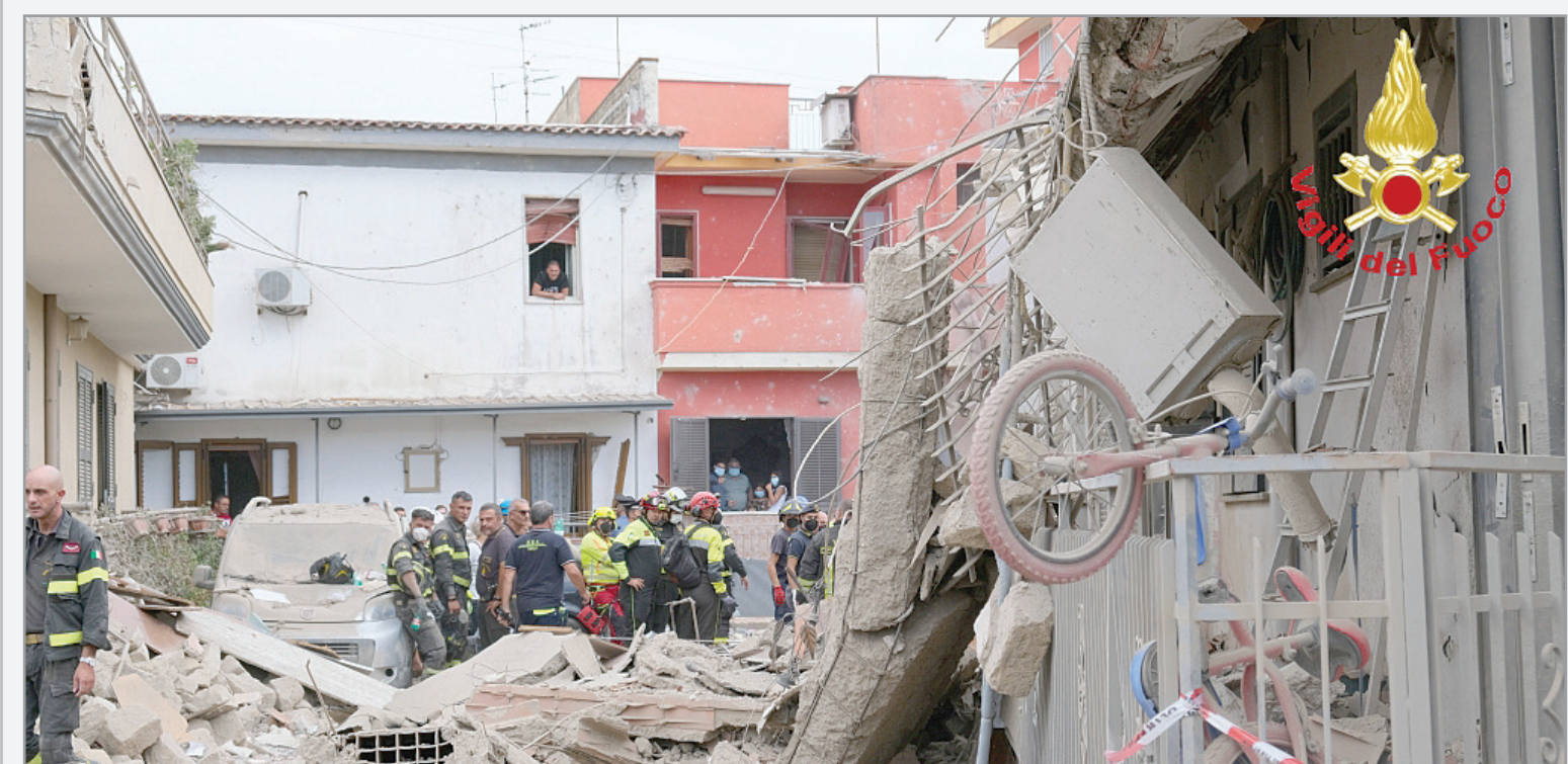
La palazzina distrutta ed i Vigili del Fuoco sul posto, per tutta la giornata di ieri (foto: Vigili del Fuoco)
